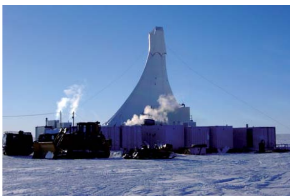
Der ANDRILL-Bohrturm auf dem Eis im McMurdo-Sund (Foto: F. Niessen)
